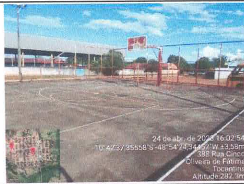
FOTO 02 - PISO DA QUADRA DE ESPORTE
