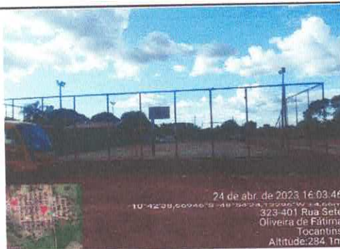
FOTO 05 - ALAMBRADO DA QUADRA DE ESPORTE
